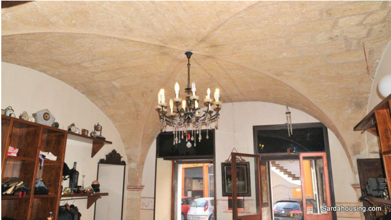
4 -- Sassari: House Castello -- Corso Vittorio Emanuele: vaulted ceilings in the cellars
