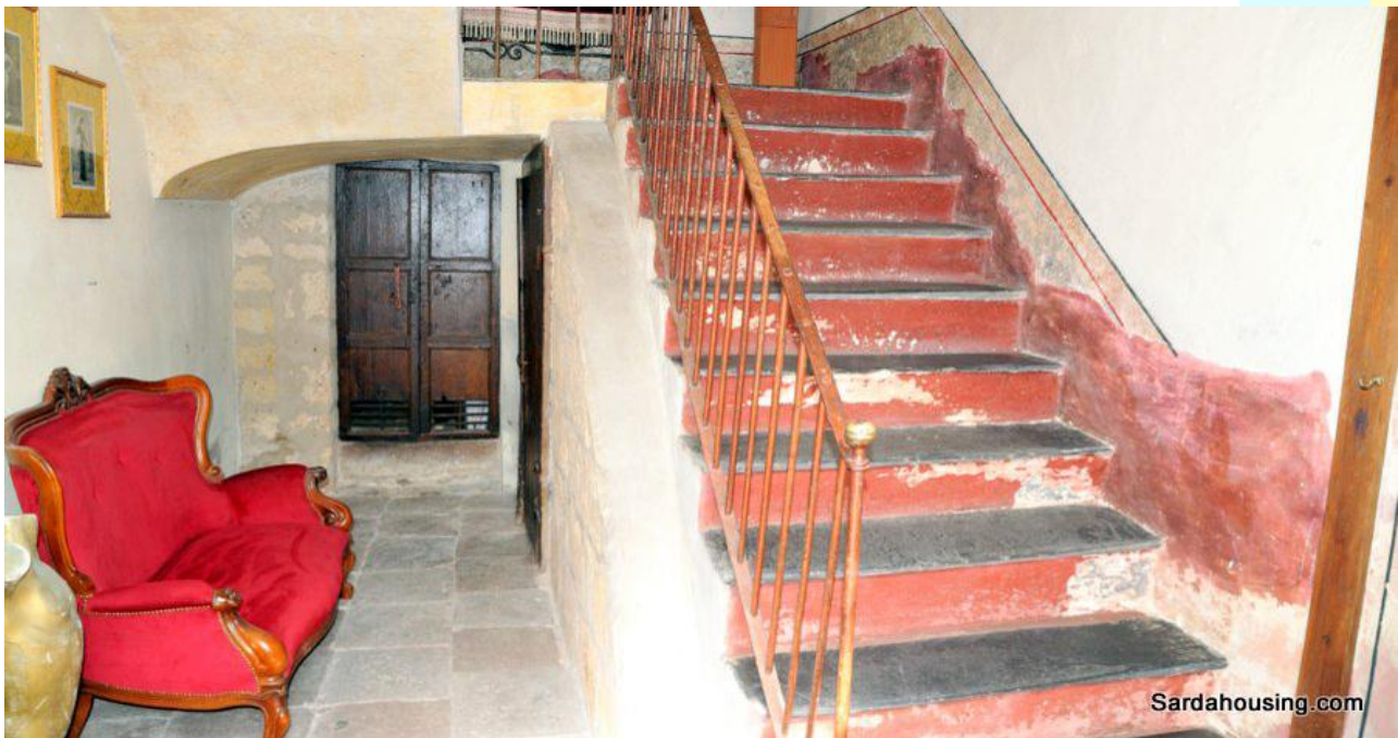
5 -- Sassari: House Castello -- Corso Vittorio Emanuele: stairs
