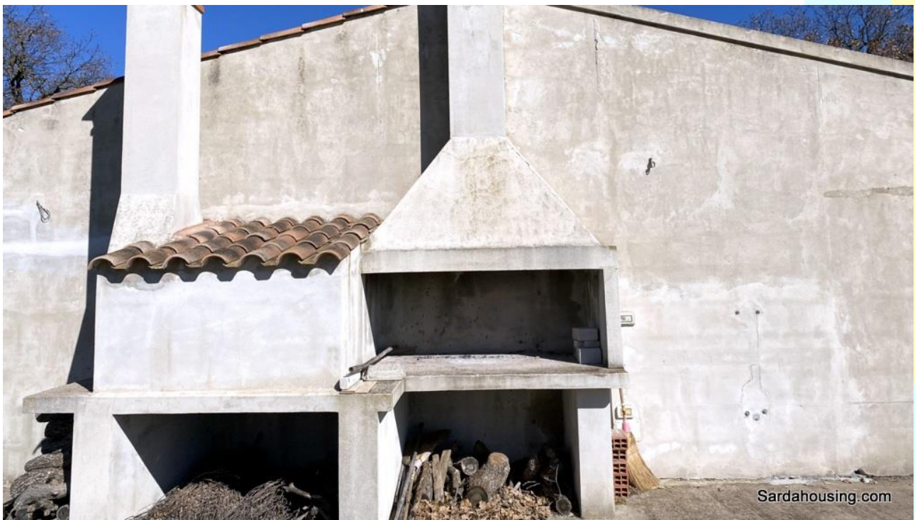
18 - Campagna di Abbasanta – Loc. Aiga – Podere Aiga: casa principale, barbecue e forno in muratura
