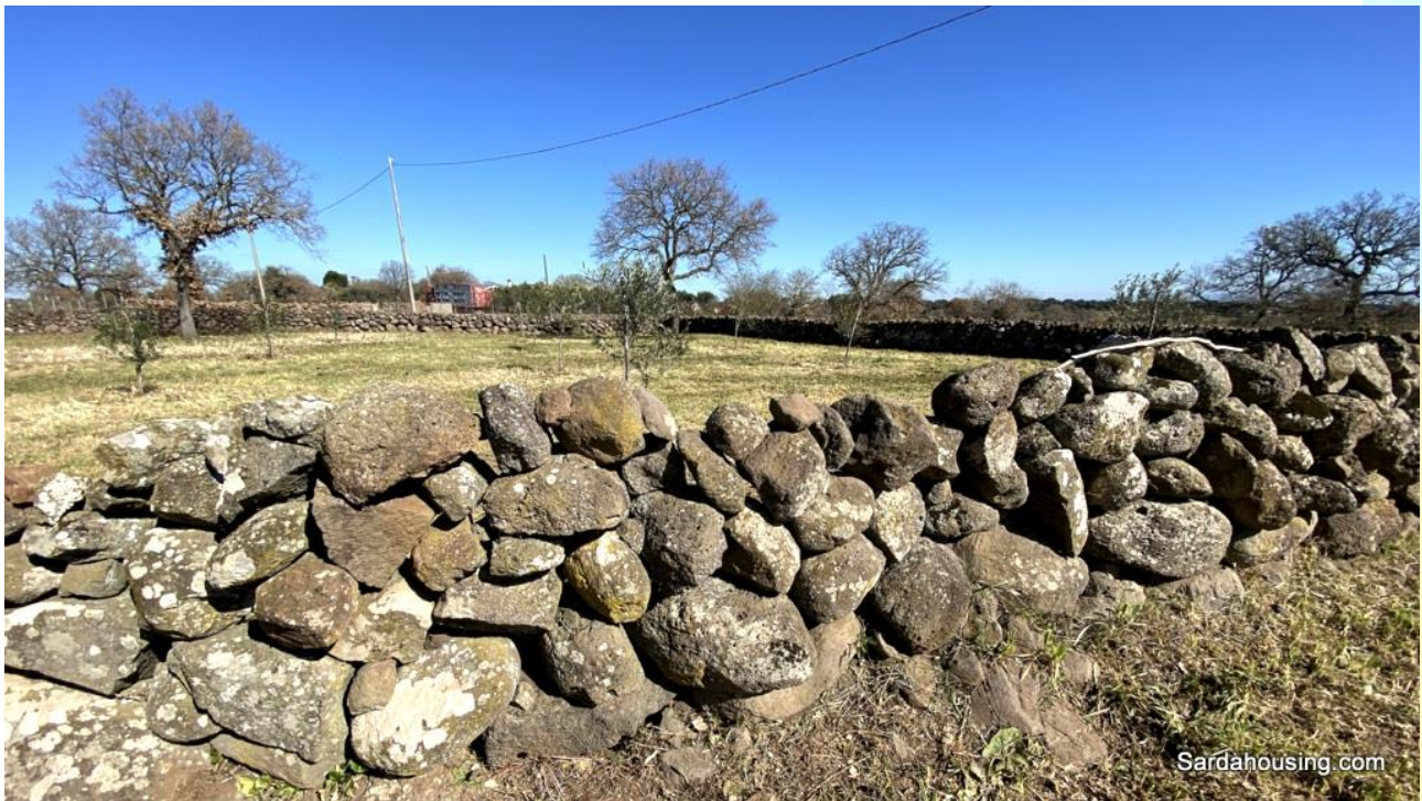
29 - Campagna di Abbasanta – Loc. Aiga – Podere Aiga: recinzione del terreno con muri a secco
