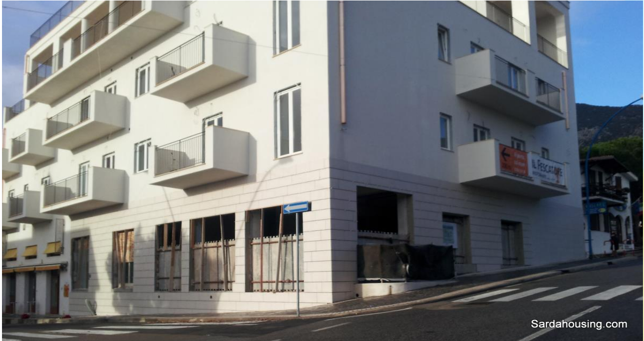
25 - Cala Gonone – Dorgali – Appartamenti Amerigo: l'edificio riqualificato
