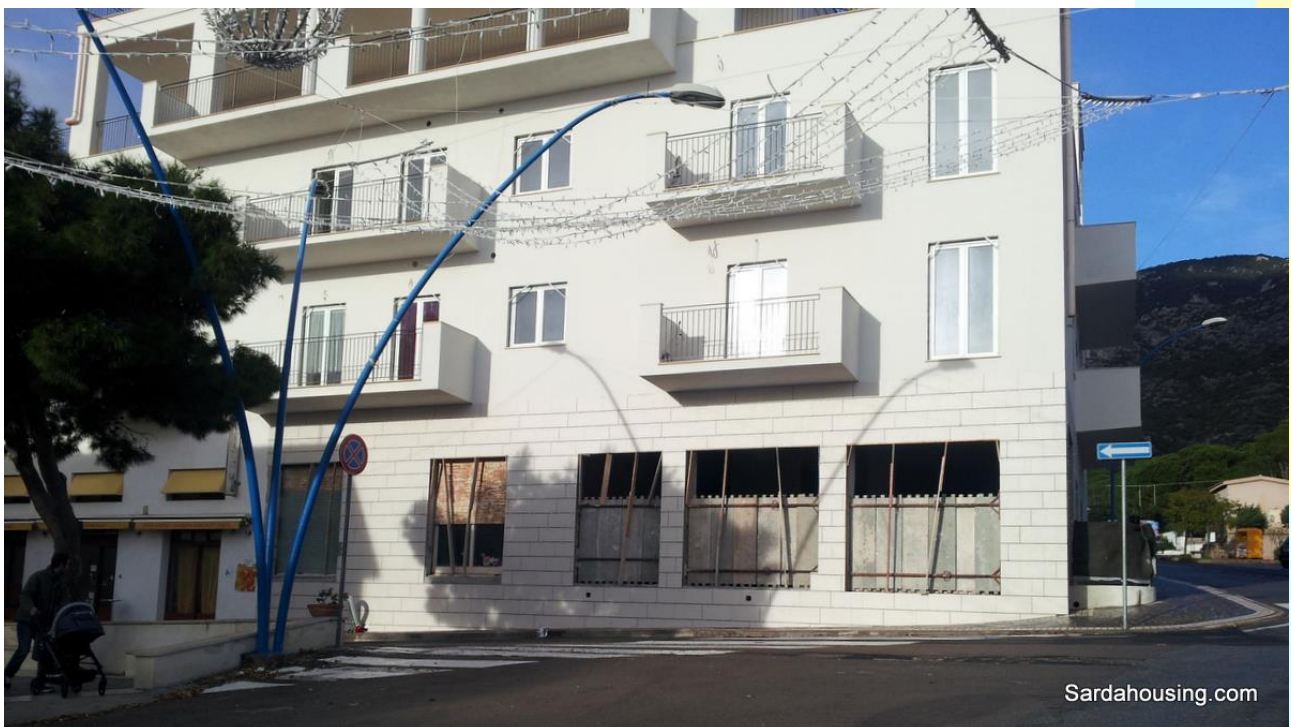
24 - Cala Gonone – Dorgali – Appartamenti Amerigo: l'edificio riqualificato
