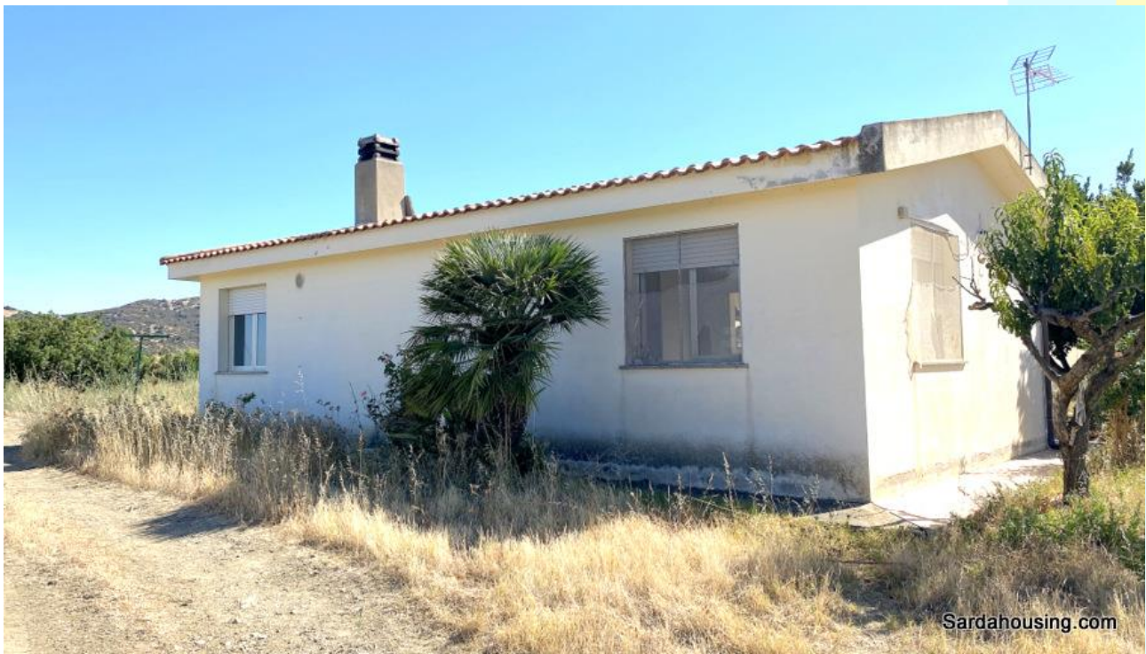
13 - Soleminis – Località Sa Spinarba: warehouse/cellar
