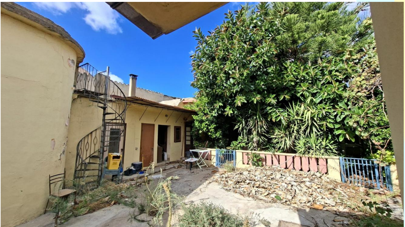
4 -- Casa Settembre -- Quartu S. Elena, centro storico -- facciata e cortile
