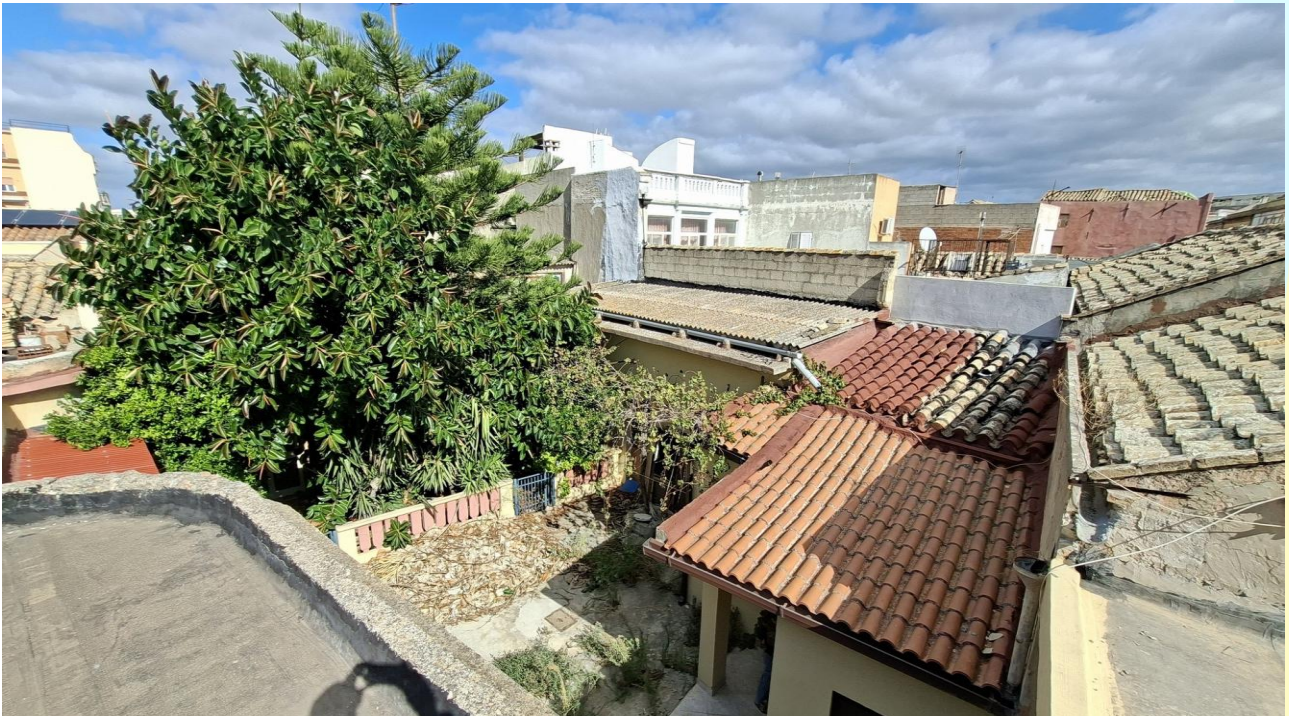
8 -- Casa Settembre -- Quartu S. Elena, centro storico -- visa da sopra
