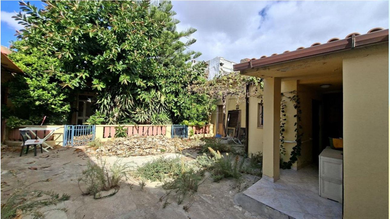
3 -- Casa Settembre -- Quartu S. Elena, centro storico -- cortile interno
