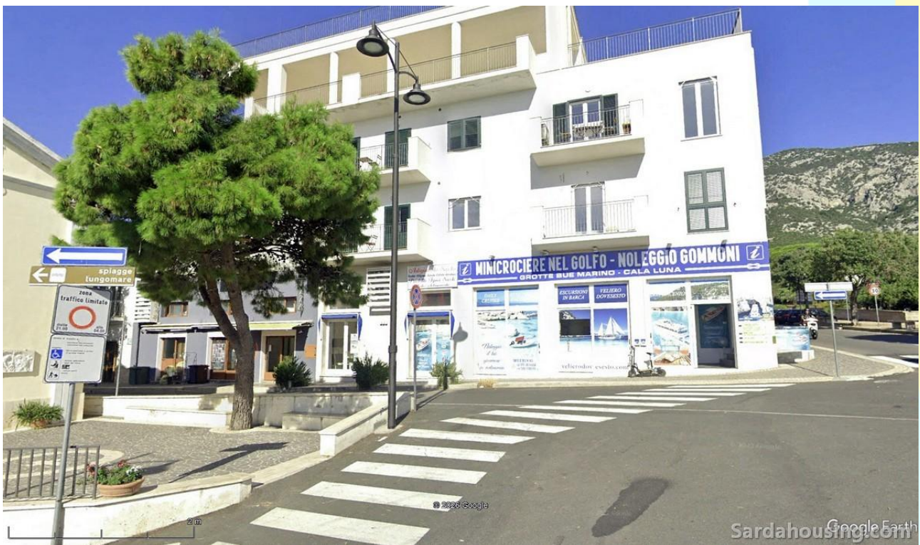
22 - Cala Gonone – Dorgali – Appartamenti Amerigo: l'edificio interamente riqualificato
