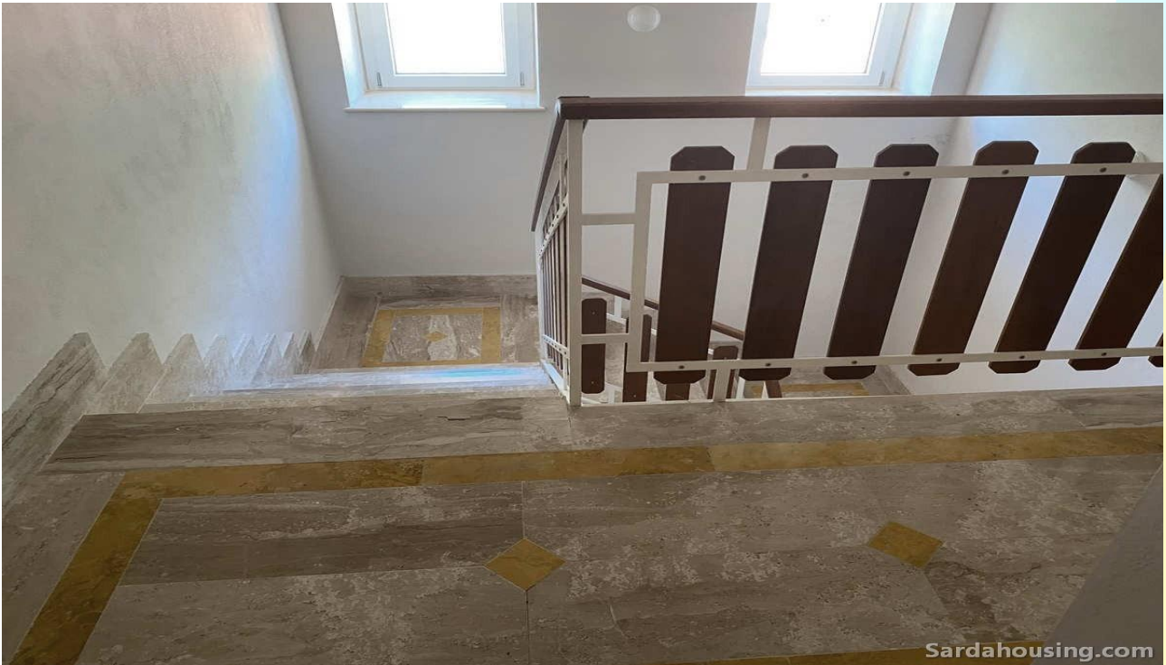
19 - Cala Gonone – Dorgali – Appartamenti Amerigo scale condominiali
